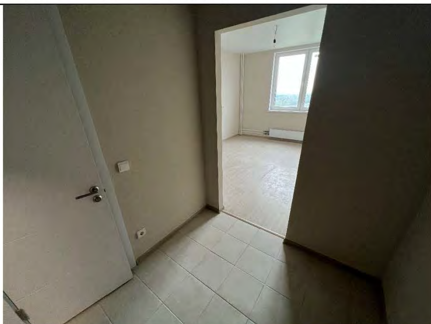
Фото №1. Общий вид коридора.
