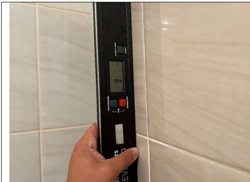
Фото №10. Измерение уровня стен в ванной комнате.
