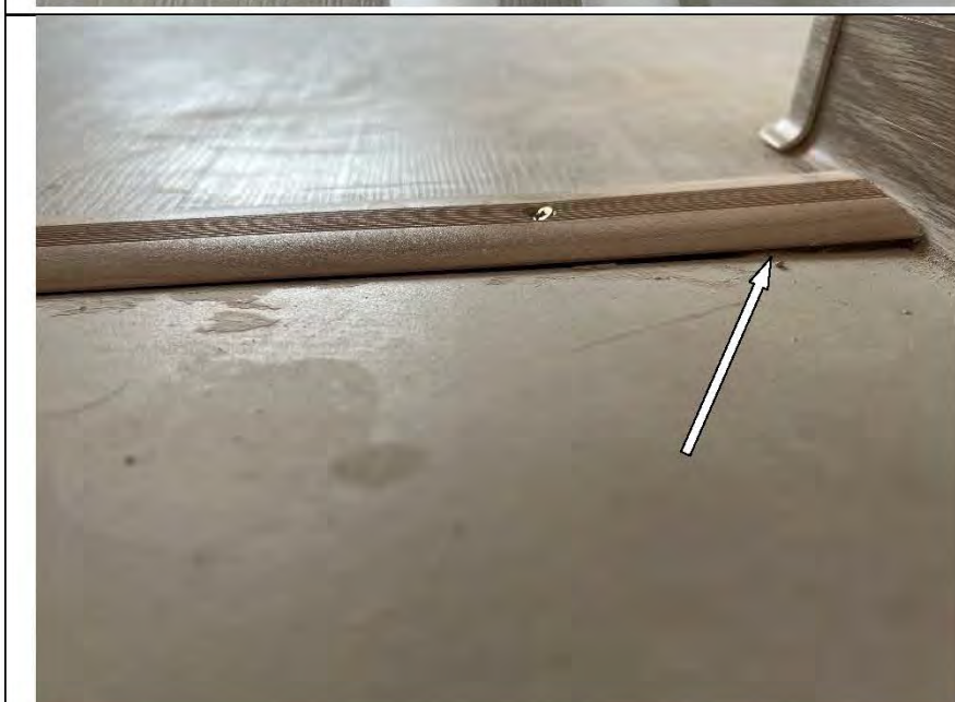
Фото №33. Зазор между металлическим порожком и поверхности напольной керамической плитки в коридоре.
