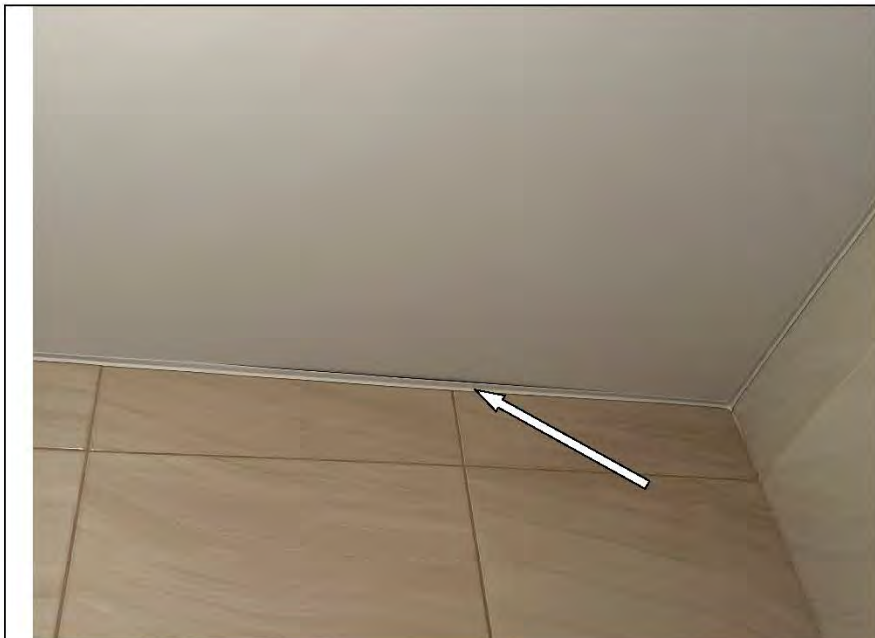
Фото №22. Зазор между декоративным молдингом и полотном натяжного потолка в ванной комнате.
