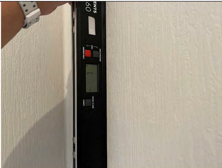
Фото №5. Измерение уровня стен в коридоре.
